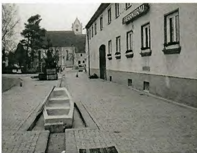
Die Situation am Wasserband kurz vor dem Abschluss der Sanierungsarbeiten, Blick vom Enzlerhaus zur Kirche.
